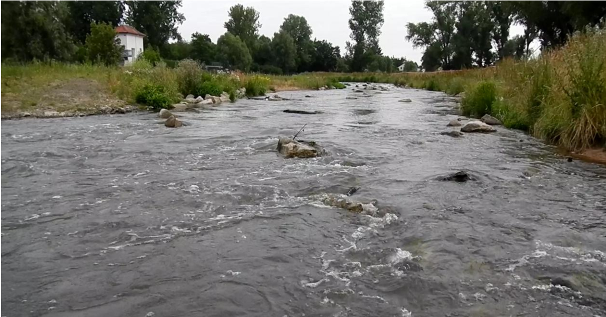
Abbildung 2: Raue Rampe am Höchster Wehr
